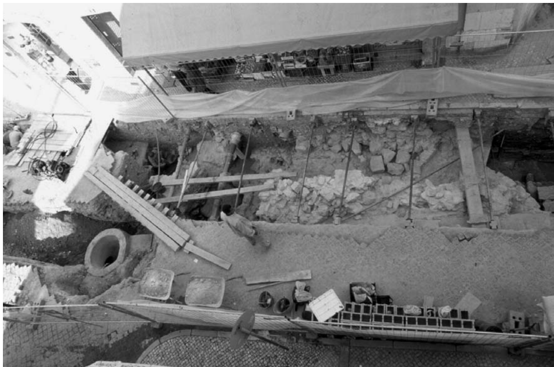
Fig. 7 Vista geral em que se pode observar o troço de muralha colocado a descoberto e o arranque de uma torre semicircular.
