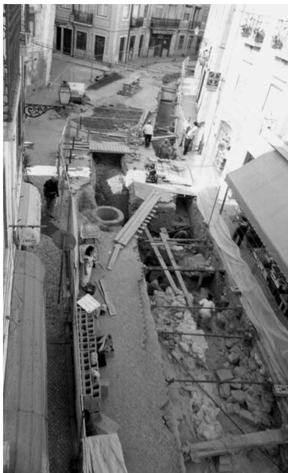
Fig. 6 Vista geral da área da intervenção.
